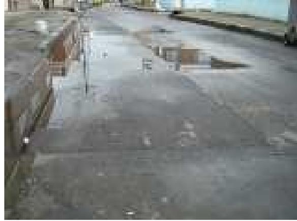
*Foto N° 6. Se evidencia que existe tramo ejecutado parcialmente con reparcho parcial posterior, el cual presenta apozamiento de agua.*
