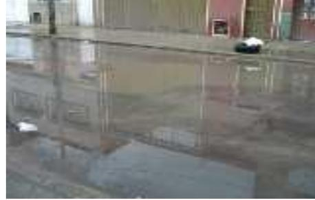
*Foto N°4. se presenta un apozamiento superficial con hundimiento y fractura de material, incluir dentro de observaciones para estabilidad de obras por garantía.*
